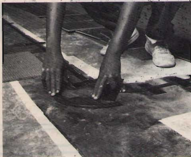
Figura 4. I quadrotti di moquette o le piastrelle, che ricoprono completamente il collegamento piano delle fibre ottiche, vengono spesso applicati con un particolare adesivo, che ne permetta una facile rimozione per eventuali interventi futuri. I cavi a fibra ottica non richiedono schermature né alcuna protezione particolare.
