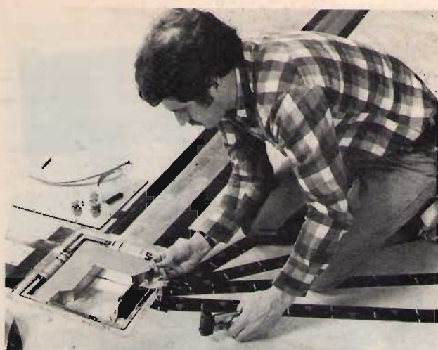
Figura 6. I tecnici eseguono una giunzione fra gli elementi piani e quelli di curvatura del cavo a fibra ottica. Si vede l'utensile per la tranciatura ad alta precisione del cavo.
