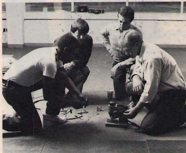
Figura 3. Accessori e utensili particolari semplificano l'installazione del cavo a fibra ottica.
